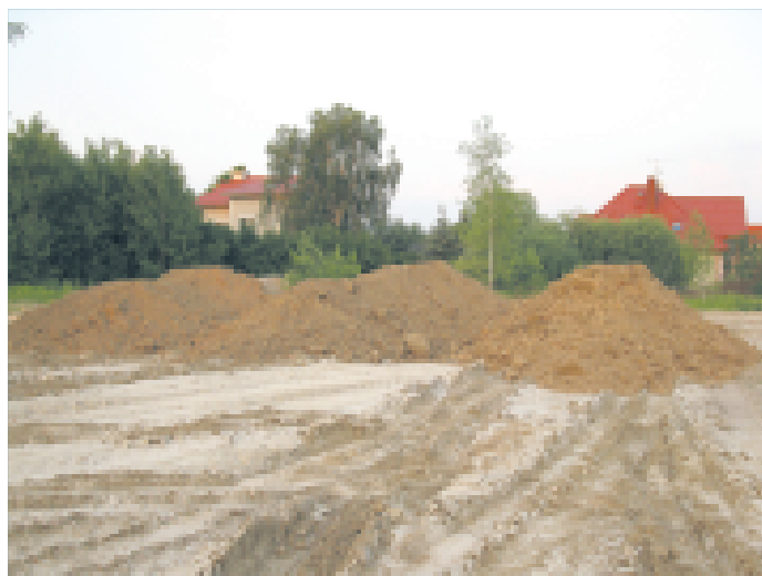
ziemia przygotowana na podwyższenie terenu
